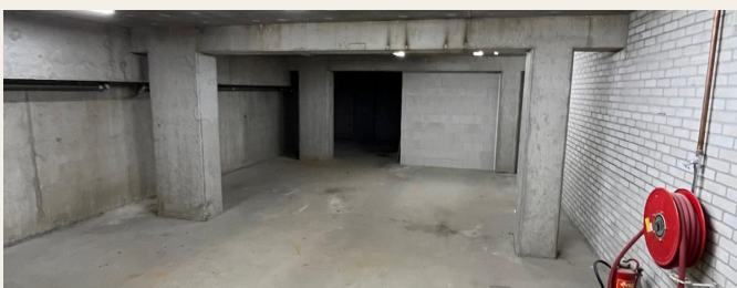
Foto huidige staat · kelder overzicht
